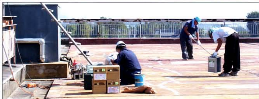
(屋上防水工事)
